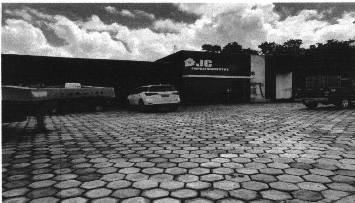
FOTO 03 – PARTE EXTERNA (GARAGEM)
