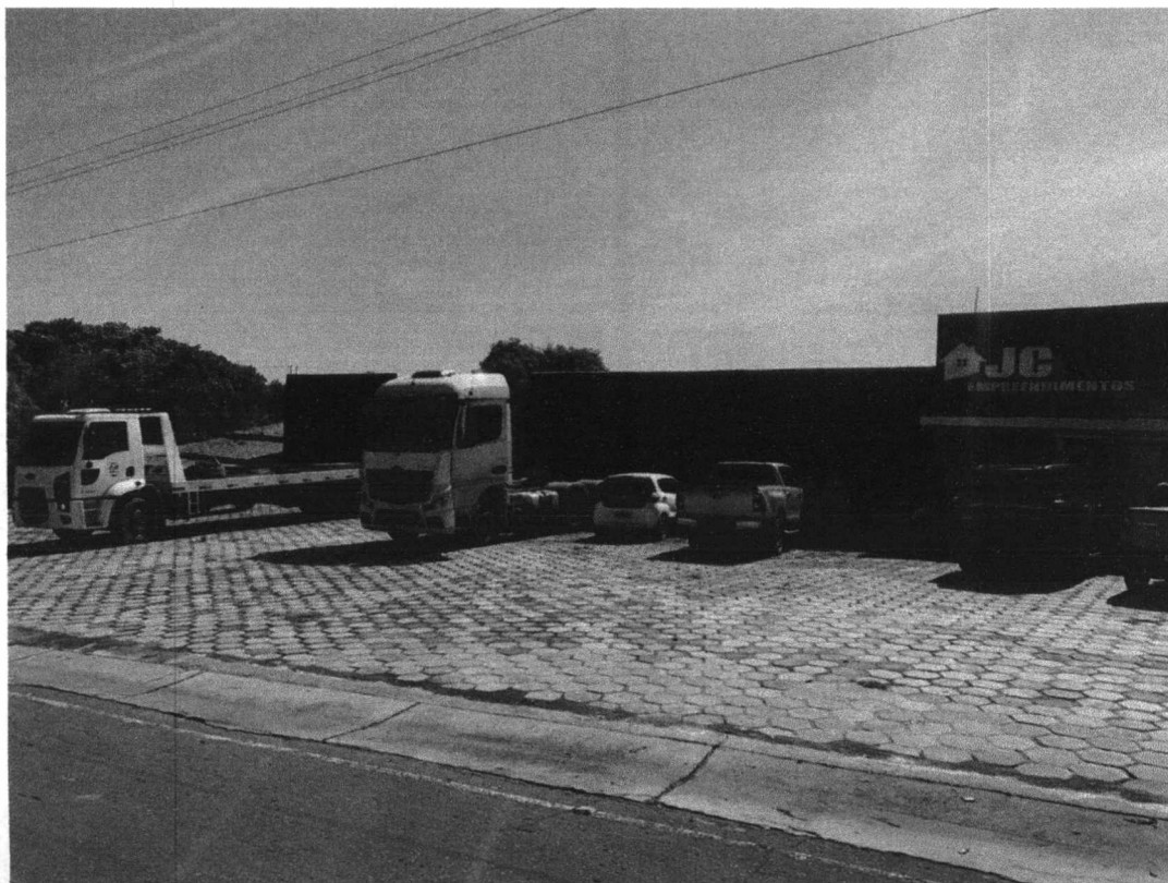
FOTO 09 – PARTE EXTERNA (GARAGEM)
