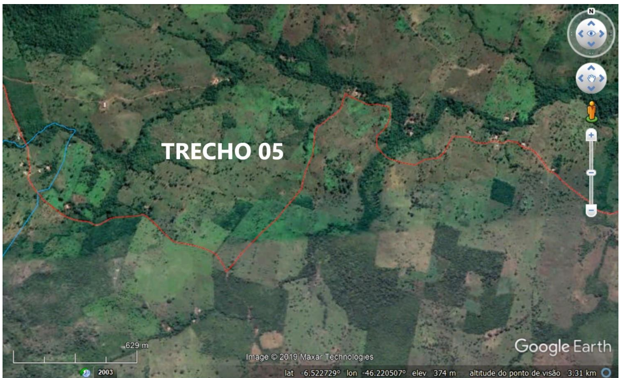
Foto 06: Trecho 05 da Estrada da Bacaba. (coordenadas geográficas)
