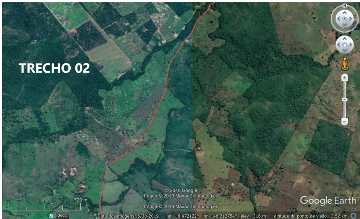
Foto 03: Trecho 02 da Estrada da Bacaba. (coordenadas geográficas)
