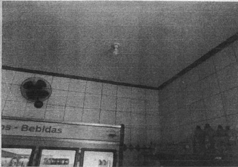
ÁREA COMERCIAL (PANIFICADORA)
